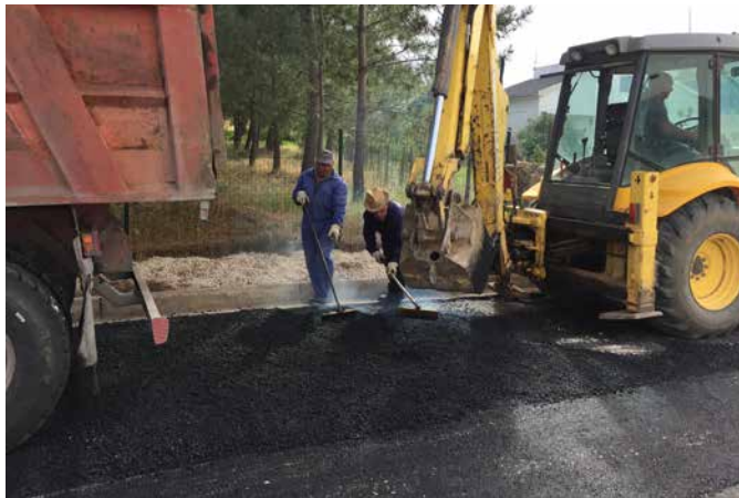
SMSPSL Alcatroamento - Trás do outeiro - Rua Principal
