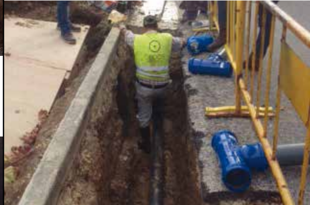
ÓBIDOS Construção de redutora de pressão
