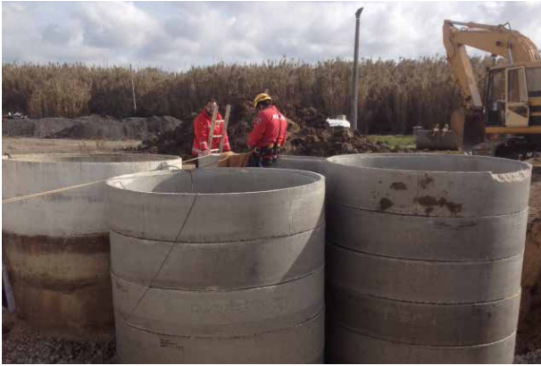
ÓBIDOS Apoio à construção de reservatório nos Bombeiros
