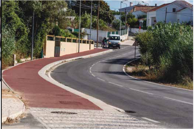
SMSPSL Conclusão da Ciclovía - A-da-Gorda
