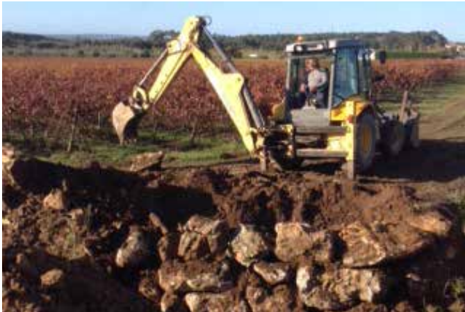
GAEIRAS Reforço do Aqueduto Pluvial - Estrada da Califórnia
