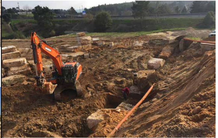
GAEIRAS Construção de Saneamento e Muro de Suporte - Zona Industrial
