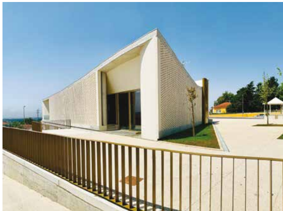
GAEIRAS Obras do Largo de São Marcos
