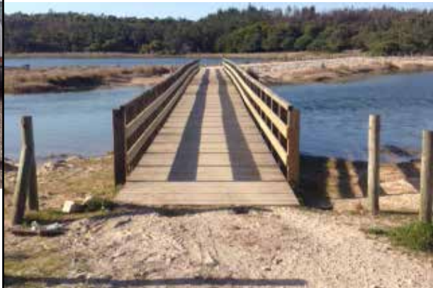
VAU Reparação da Ponte da Ferraria
