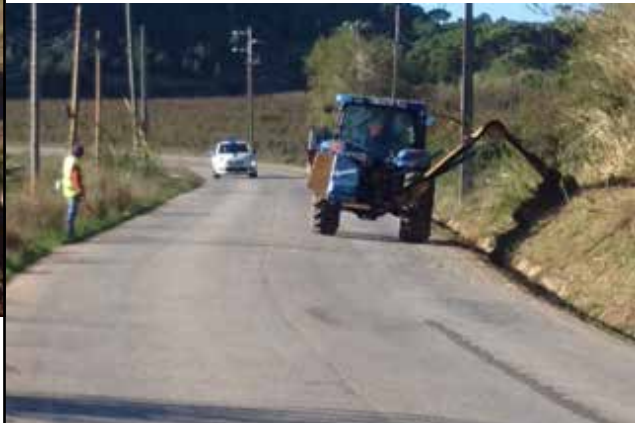
SMSPSL Limpeza de bermas e taludes
