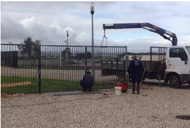
ÓBIDOS Obras de Conservação dos Gradeamentos dos Complexos Escolares
