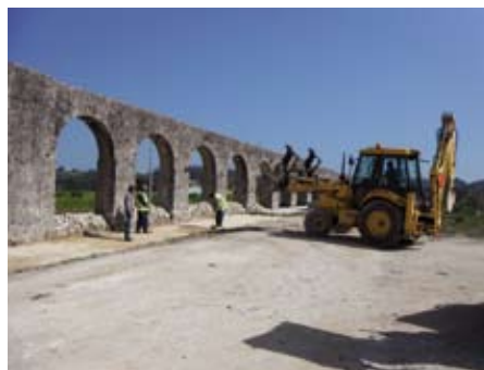
STA. MARIA, S. PEDRO E SOBRAL Preparação do caminho pedonal junto ao aqueduto para calcetamento
