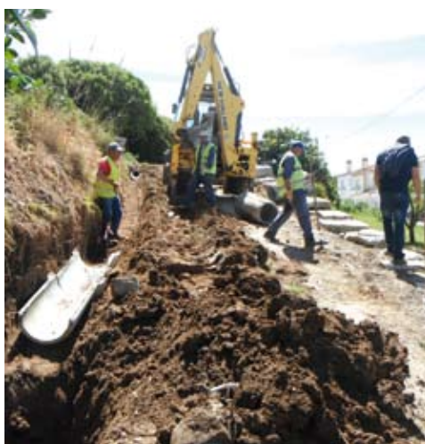
A-DOS-NEGROS Construção de linhas de águas com manilha
