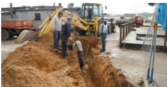
OLHO MARINHO Obras nas novas instalações do parque desportivo
