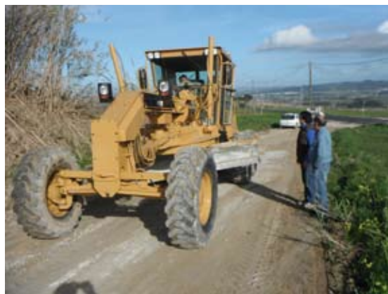
OLHO MARINHO Reparação e colocação de ton-nen em diversos caminhos rurais
