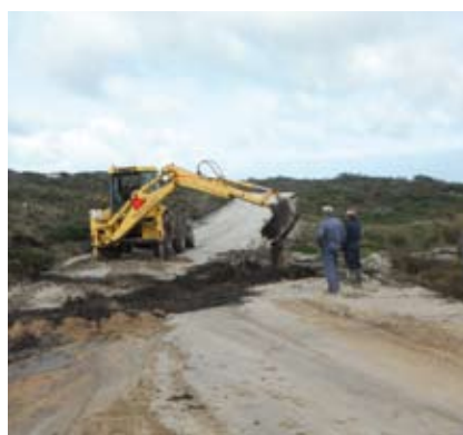
VAU Construção de diversos pontões
