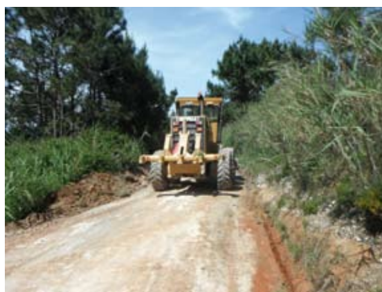
USSEIRA Reparação e manutenção nos caminhos rurais
