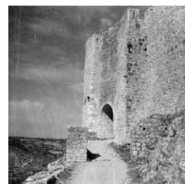
VISTA GERAL DA PORTA DA CERCA, COM ESTRUTURA E A CALÇADA (Fonte: Arquivo Fotográfico da DGMN)
