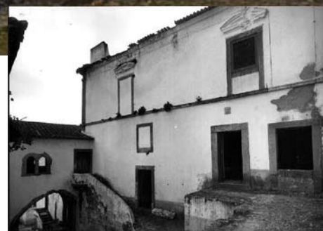
ASPEITO DO EDIFÍCIO, ANTES DAS OBRAS DE ADAPTAÇÃO A MUSEU MUNICIPAL (Fonte: Arquivo Municipal de Óbidos)
