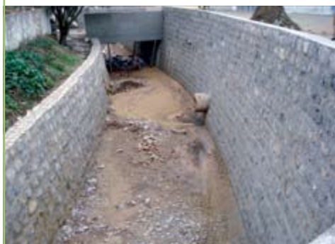
OLHO MARINHO Emparedamento da vala de água
