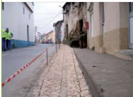
USSEIRA Calcetamento de bermas
