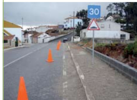
VAU Calcetamento de passeios
