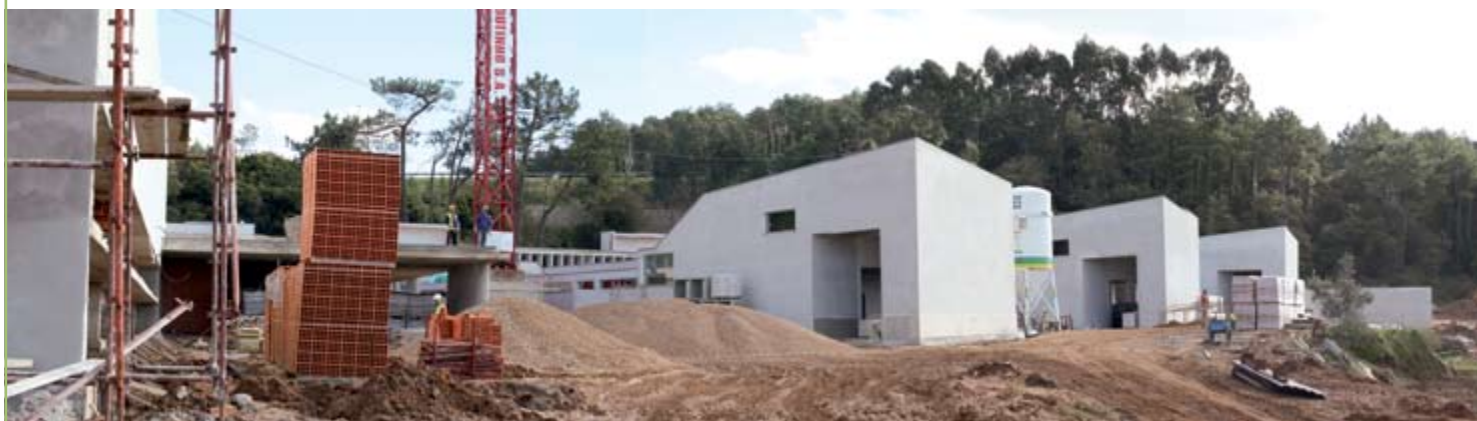
ÓBIOS Obras de construção do Complexo escolar
