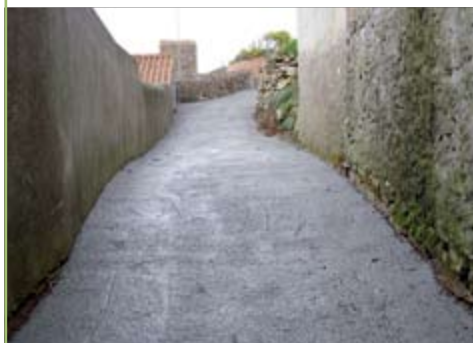
SOBRAL DA LAGOA Pavimentação da Travessa das Eiras
