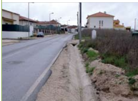
SANTA MARIA Construção de bermas em cimento
