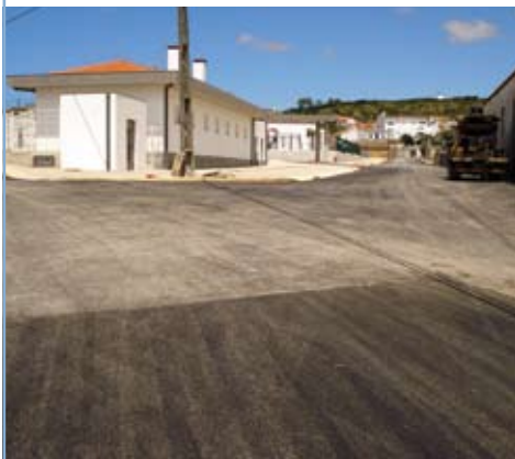
AMOREIRA Pavimentação da Rua da Mina
