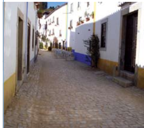
ÓBIDOS Repavimentação (em calçada) da Rua Josefa d'Óbidos
