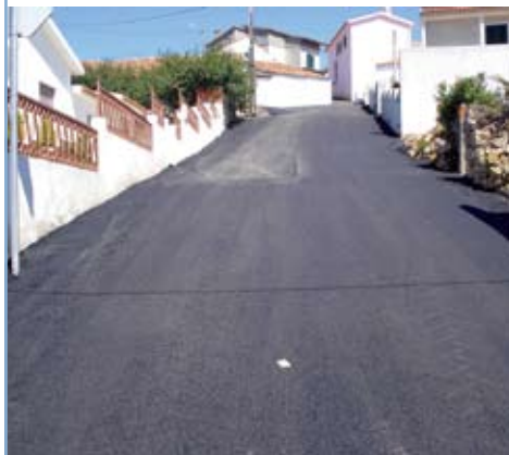
SOBRAL DA LAGOA Pavimentação da Travessa das Curvas
