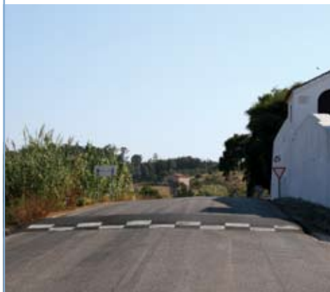
VAU Construção de lombas redutoras de velocidade
