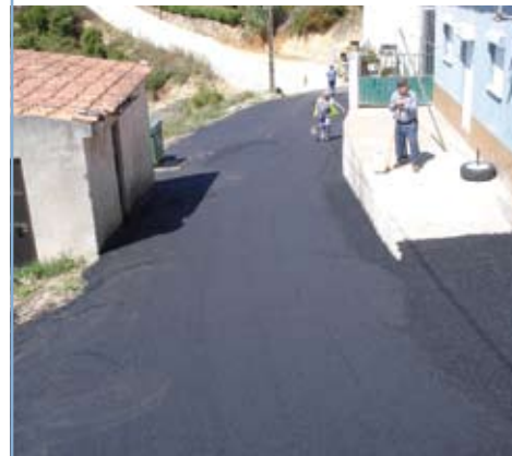
SOBRAL DA LAGOA Pavimentação da Rua da Bela Vista
