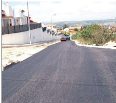
USSEIRA Alcatroamento da Rua do Outeiro e Rua do Talefe
