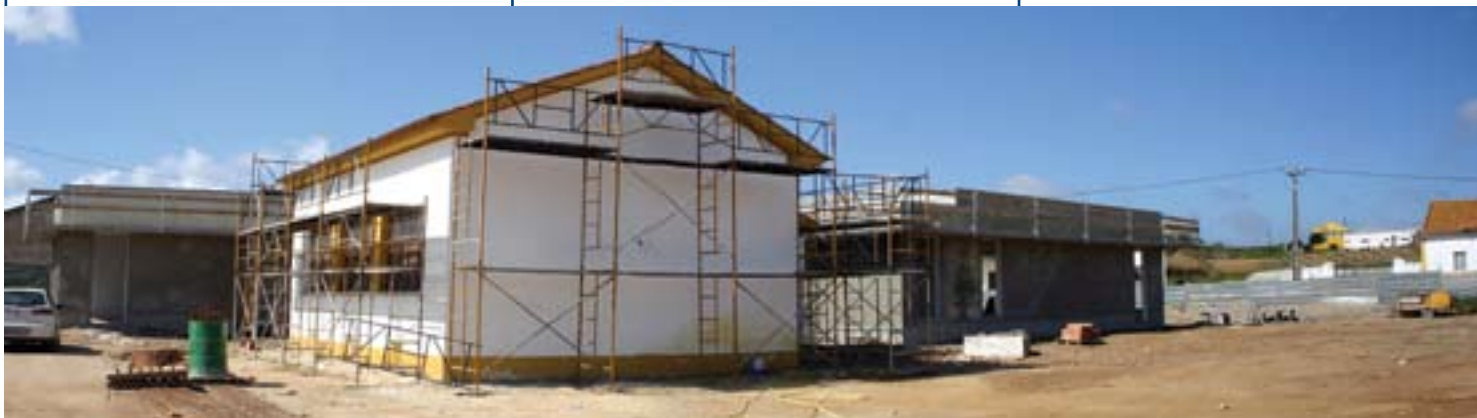
ARELHO Construção do Jardim-de-Infância
