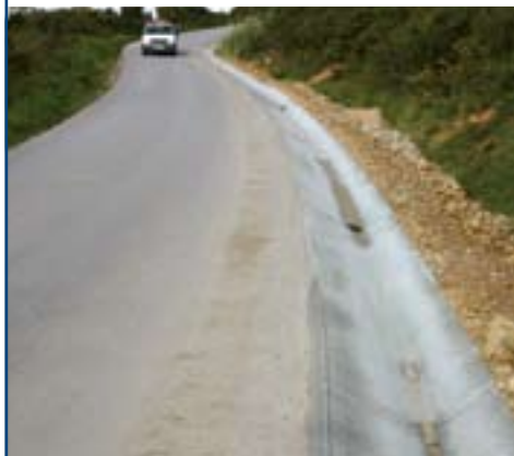
CONCELHO Continuação da construção de valetas em cimento
