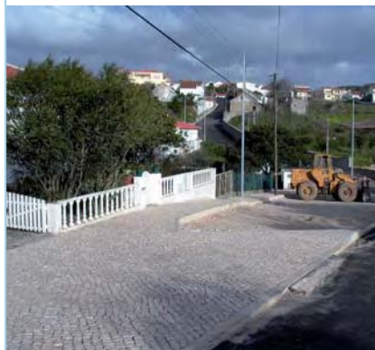
GAEIRAS Continuação do calcetamento na rua do Ribeiro, nas Gaeiras
