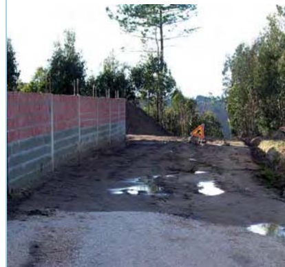
GRACIEIRA Colocação de saneamento básico no Alto Redondo
