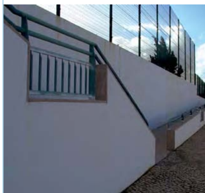
GAEIRAS Arranjos exteriores do parque escolar nesta freguesia
