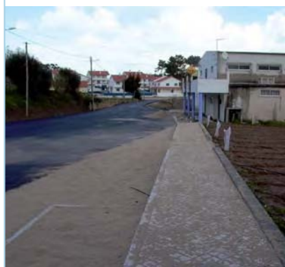
TRÁS DO OUTEIRO Colocação de passeios em alguns arruamentos desta localidade
