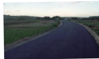
Uma via fundamental no concelho - alcatroamento da estrada Vau/Arelho
