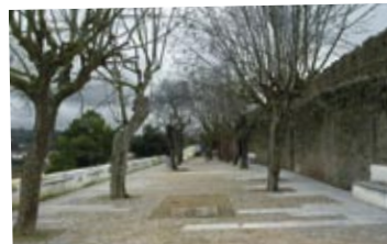
Obras de beneficiação no miradouro do Jogo da Bola
