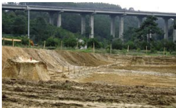
Estão no início as obras nas Piscinas Municipais de Óbidos
