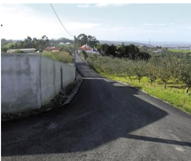
5 - Amoreira: Depois da beneficiação, sinalização e iluminação da EN 114, junto a esta localidade, foram já colocados os novos abrigos nas paragens de autocarros de transporte público de passageiros.
