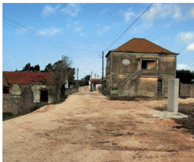
2 - Bairro dos Arcos: beneficiação e alcatroamento de estradas.
