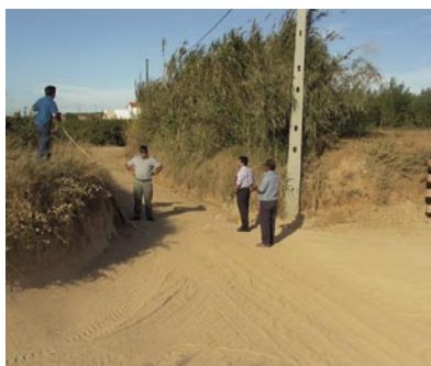
11 - Abertura e alargamento do caminho de ligação entre a Usseira e a Capeleira. Com este melhoramento a população do Casal das Netas e outros ficam com uma nova ligação à sede de concelho.
