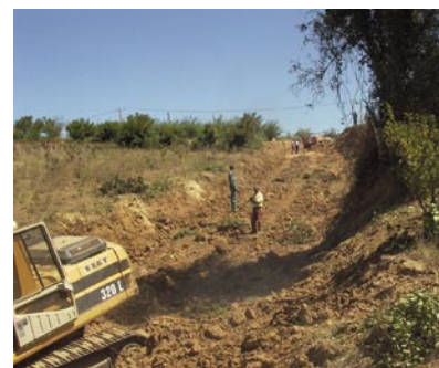
13 - Estrada Usseira / Capeleira - Trabalhos de alargamento.
