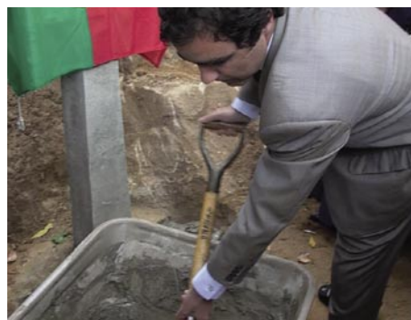
5 - As primeiras pás de cimento para esta estrutura foram colocadas por Sevinato Pinto e Telmo Faria
