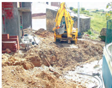
11 - Sancheira Grande obras de saneamento
