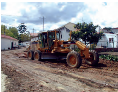
2 - Casal da Arruda preparação do piso para alcatroamento de ruas(antes)
