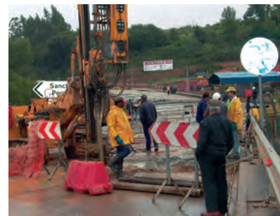
14 - Captação de água no concelho
