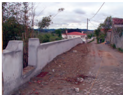
9 - Dagorda alargamento de rua e construção de um muro de suporte
