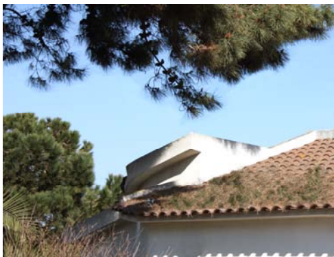
Figura 12 — Pinheiro-bravo com projecção da copa sobre a cobertura da casa e com acumulação de caruma no telhado.
