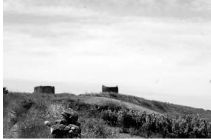
Moinhos da Zibreira – Ponto estratégico na linha da frente aliada. Aqui Lord Wellington terá colocado uma forte bateria de artilharia.
